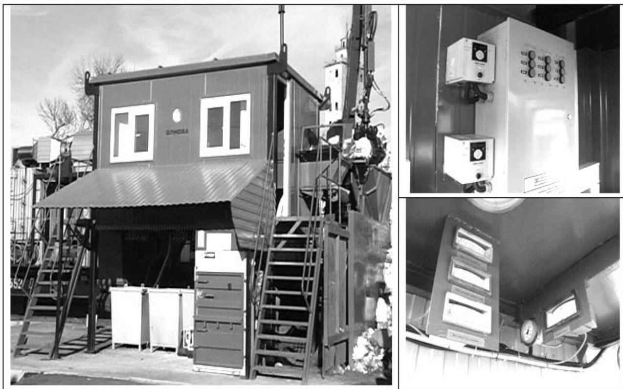
Рисунок 3. Сортувальна кабіна сміттєспалювальної установки ПМК-400.
